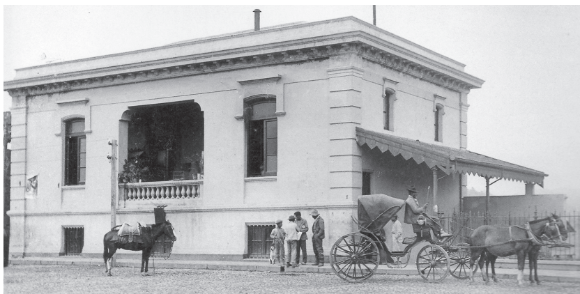
Figura 33. Edificio de Pasajeros de la Estación Jujuy antes de la remodelación. Fuente: Archivo General de la Nación.
