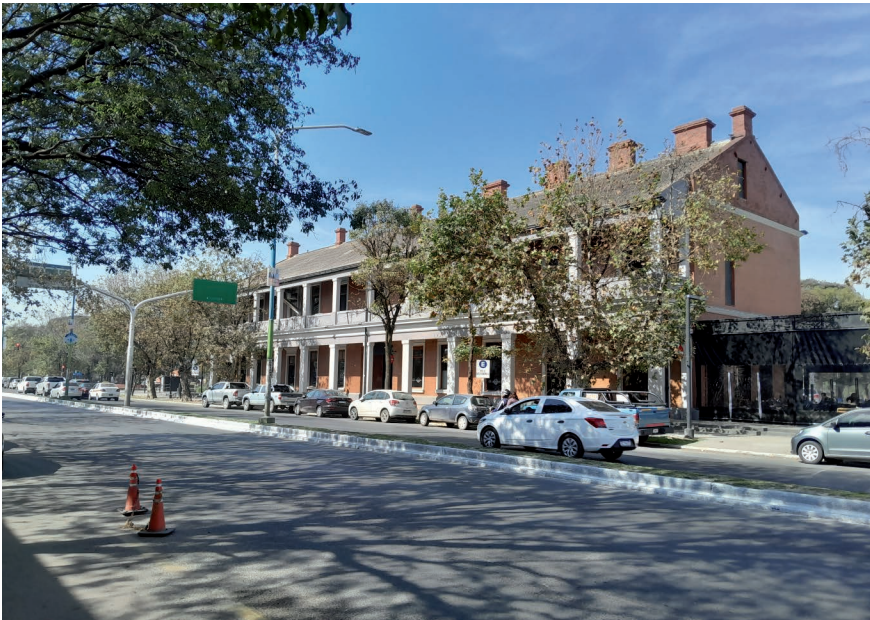
Figura 7. Edificio de Pasajeros, Estación El Provincial, 2023. Foto: M. Ferrari.
