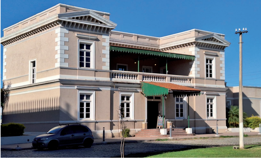
Figura 24. Edificio de Pasajeros, Estación Santiago Central Córdoba, 2023. Foto: M. Ferrari.
