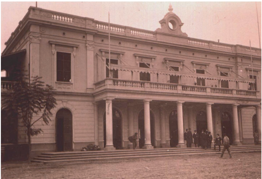
Figura 10. Edificio de Pasajeros Estación Tucumán Sunchales Mitre, 1910. Foto: Archivo General de la Nación.
