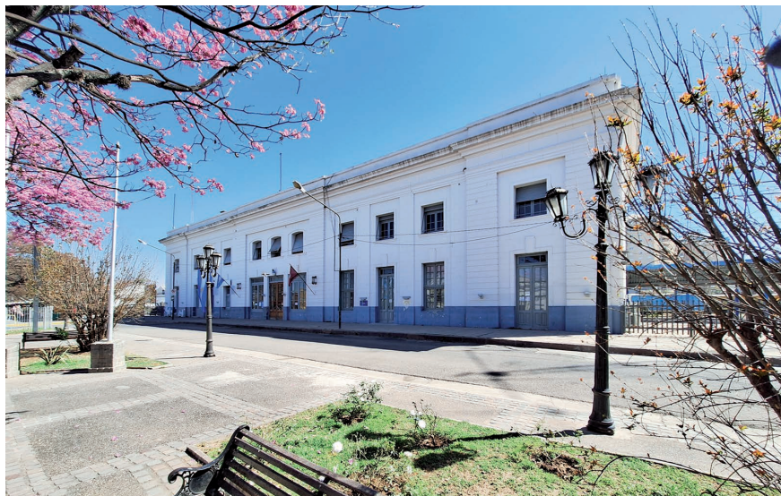
Figura 20. Edificio de Pasajeros y sector de andenes, Estación Salta, 2023. Foto: M. Ferrari.
