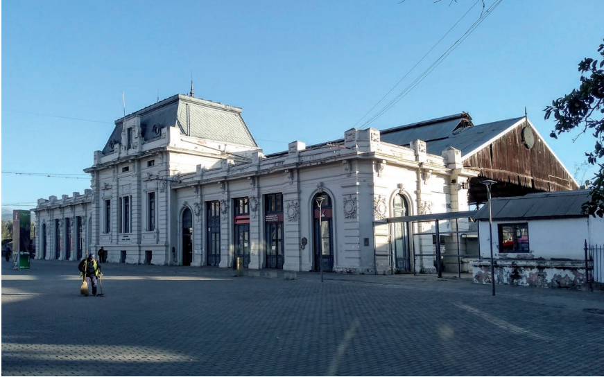
Figura 35. Edificio de Pasajeros Estación Jujuy, 2023. Foto: Alfredo Hugo Miranda.
